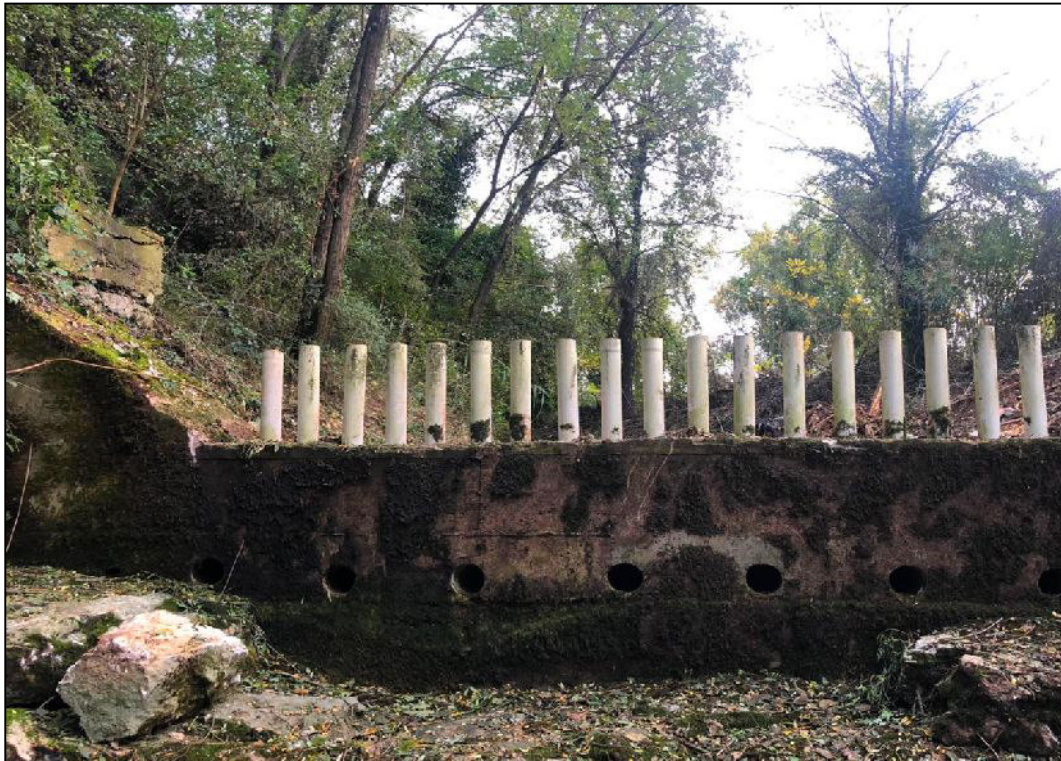
Fig. 19: torrente Pozzaveglie: briglia selettiva che introduce all'inghiottitoio.
