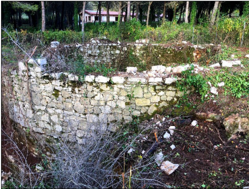
Fig. 13: esterno del Pozzo Liverani. La struttura poggia sulla roccia stabile sottostante. Le murature sono eseguite con pietre calcaree sbozzate e malta.
