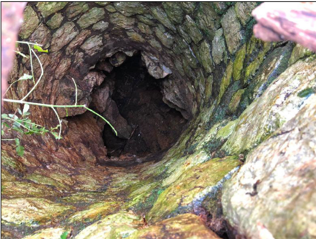
Fig. 16: Inghiotitoio Pantano. La cavità naturale è preceduta da un ingresso in muratura di pietrame e malta.
