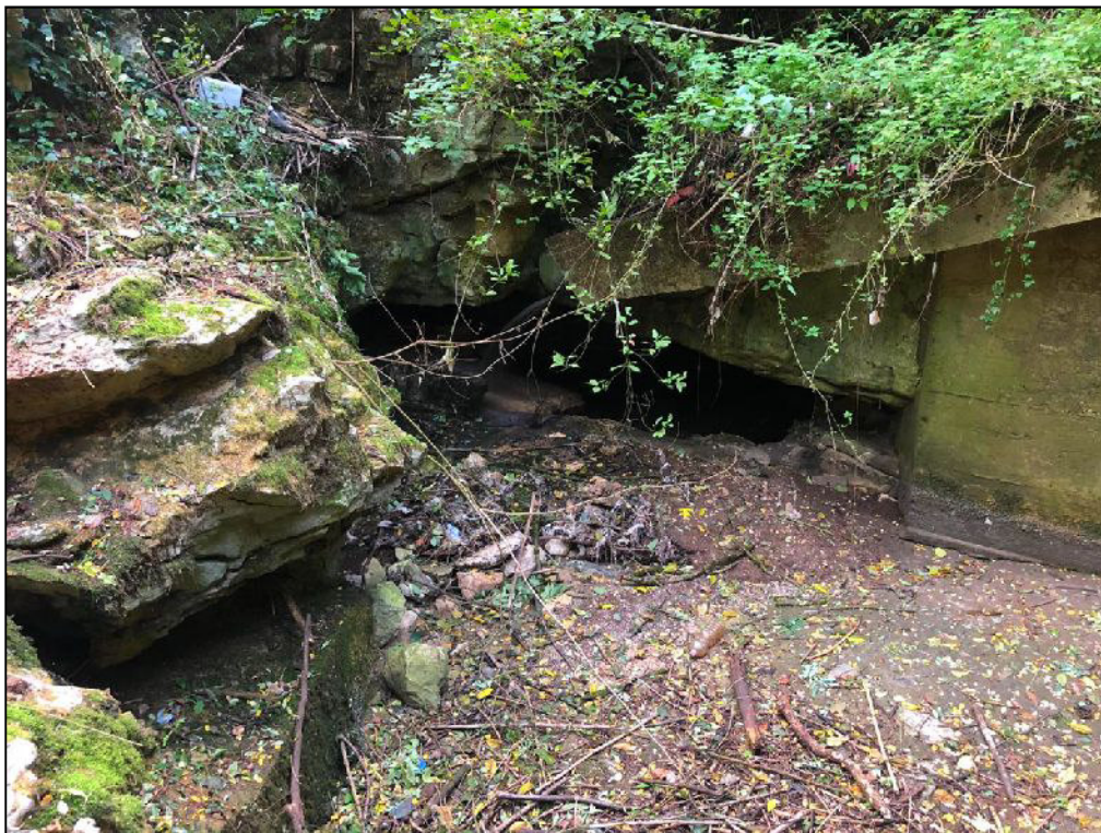
Fig. 20: ingresso della cavità naturale dell'inghiottitoio. Alcune parti esterne risultano sistemate con pareti in cemento armato.
