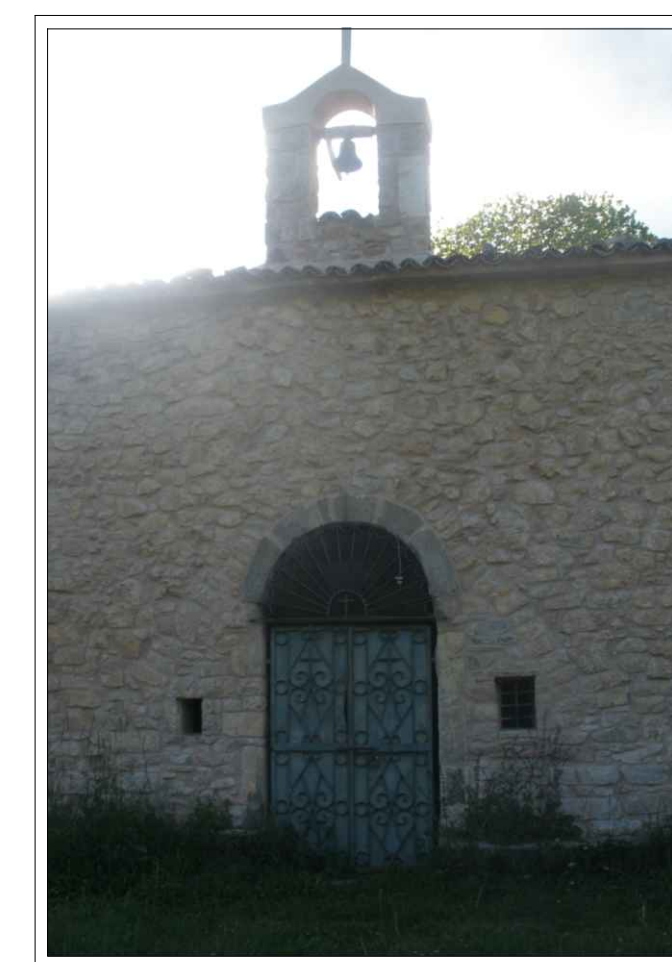
Particolare della facciata principale
