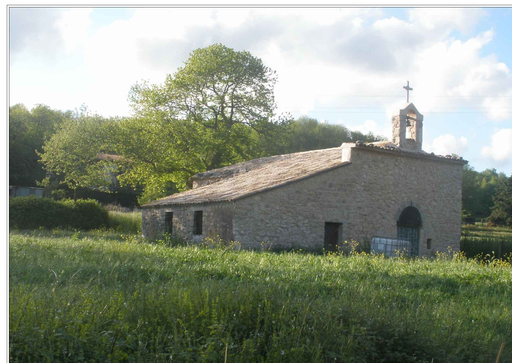
VISTA SULLA FACCIATA PRINCIPALE
