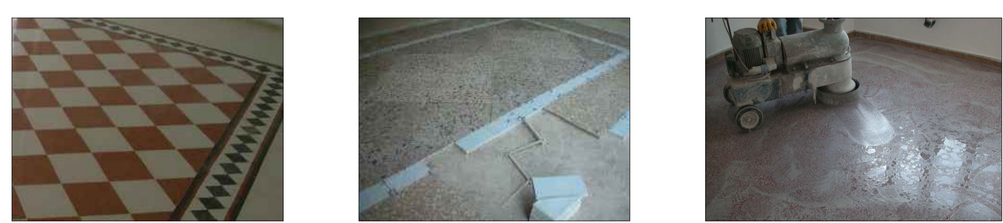
disposizione "geometrica" su pavimento d'epoca fase di montaggio levigatura
