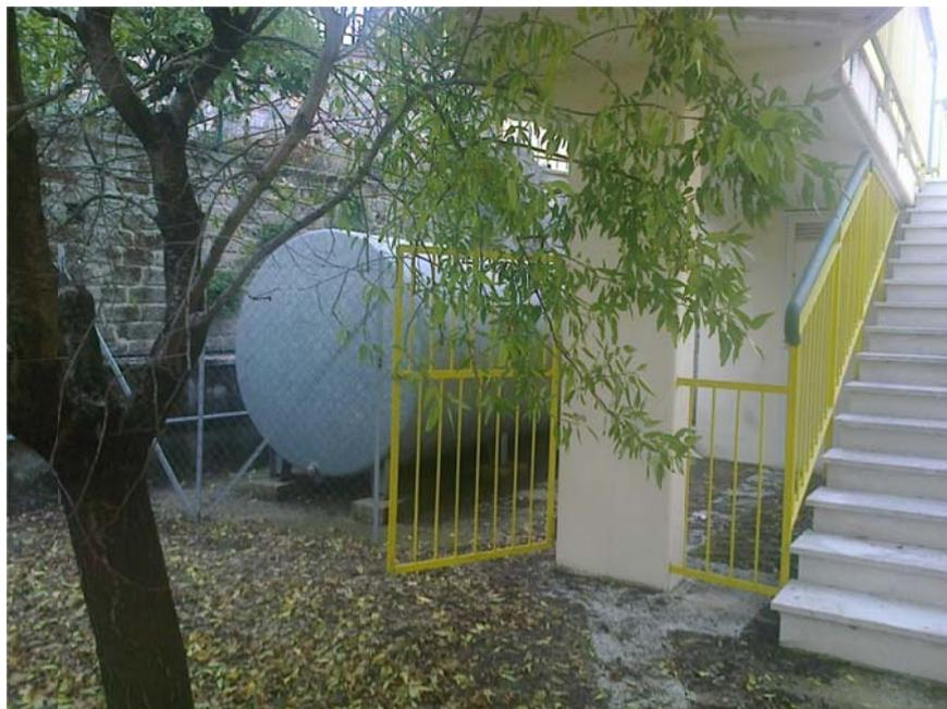
*Figura 7 – Edificio Scolastico “L. Tatarelli”, Lenola (LT) – Serbatoio per riserva idrica ai fini antincendio*
